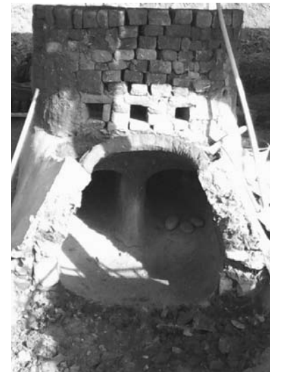
Broglio - Forno in costruzione
